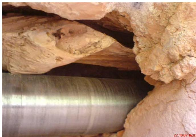
Abb. 2 : Inhomogenes Bestandsmauerwerk mit Bohrhindernissen
