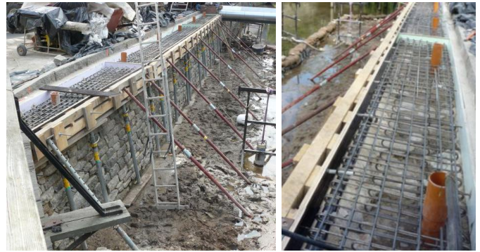
Abb.: Schalung Abdeckplatte Mauerkrone
