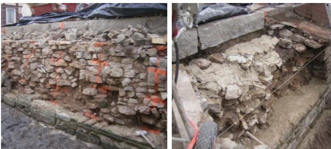
Abb.: Neuaufmauerung
