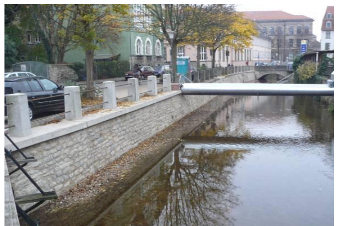
Abb.: Zustand nach der Sanierung
