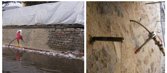
Abb.: Spritzverfugung
