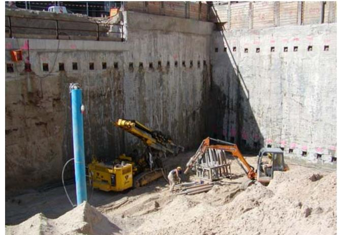
Durch den Einsatz eines Spezialbindemittels war es möglich die Temporäranker mit einer Gebrauchslast bis zu 1.014 kN schon nach zwei Tagen vorzuspannen und so wertvolle Bauzeit für den Erdaushub zu gewinnen.
