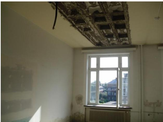
Die zum größten Teil freiliegenden Bewehrungseisen korrodierten somit an den Rippenunterseiten verdeckt durch die Heraklithplatten. Die Tragfähigkeit und der Brandschutz waren stark beeinträchtigt.
