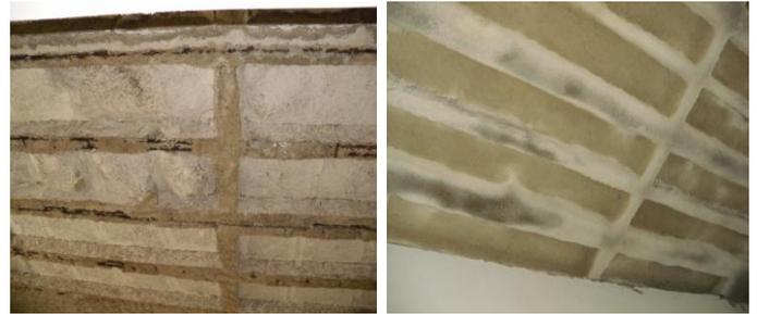
Die Schädigung wurde im Zuge von Renovierungsarbeiten 2009 festgestellt. Zur Ertüchtigung der Decken war es notwendig auf der gesamten Fläche den Putz, die Heraklithplatten und den geschädigten Beton abzutragen. Sämtliche Abbrucharbeiten konnten zur Vermeidung von Beschädigungen durch Erschütterung nur mit Kleingeräten ausgeführt werden. Staub- und lärmintensive Arbeiten wurden wegen der fortlaufenden Nutzung angrenzender Verwaltungsräume nachts ausgeführt.
