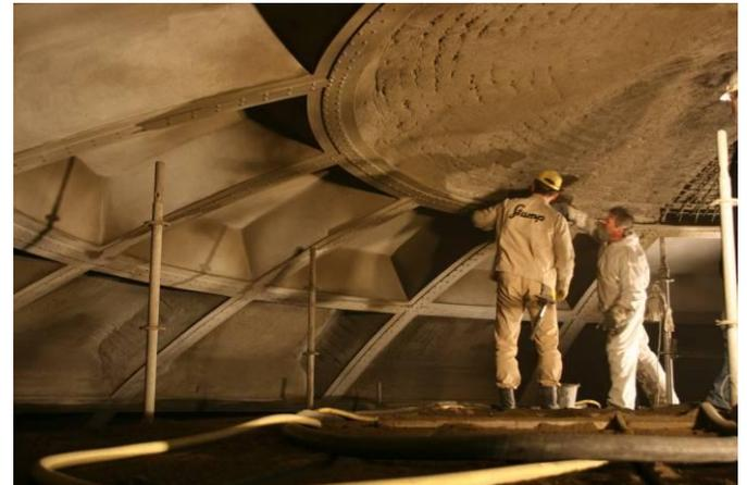
Abb.3 – Auftrag Spritzbeton
