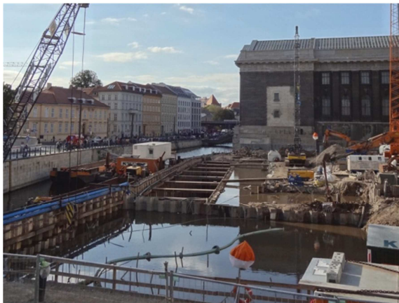
Baugrube Neues Eingangsgebäude September 2012
