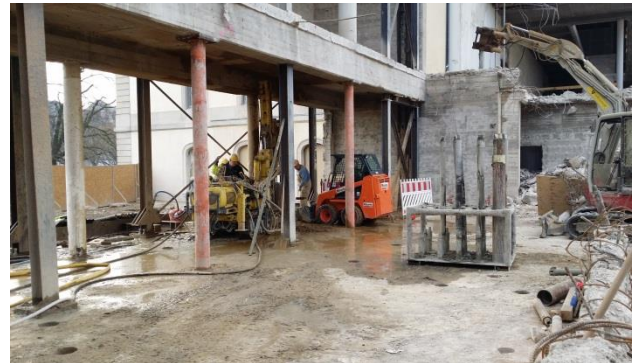
Nachgründung im Innenbereich
