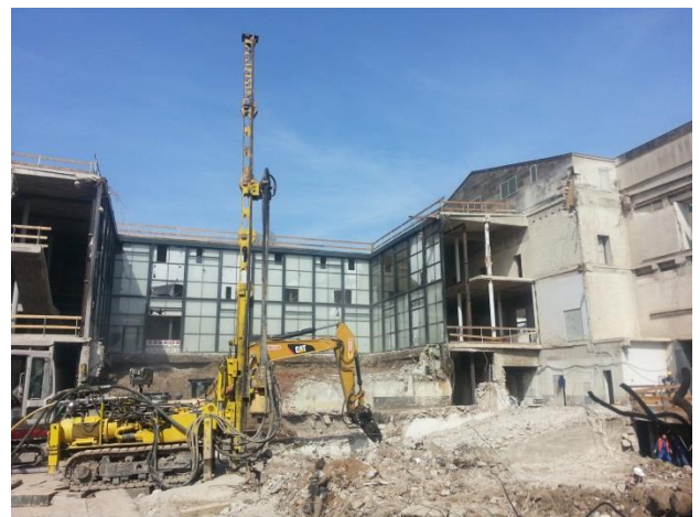
Temporäre Sicherungsmaßnahmen im Innenbereich
